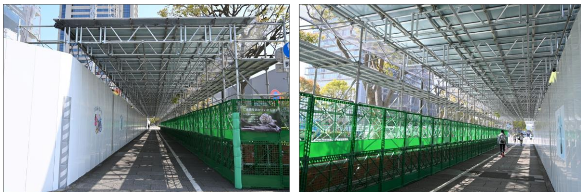
▲（仮称）みなとみらい21 中央地区37街区開発計画 MM37タワーでの試験施工風景
